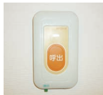
緊急通報装置(2箇所)
