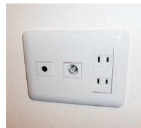
電話線用配管
