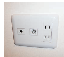
電話線用配管
