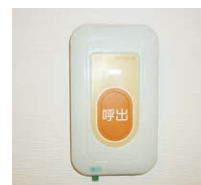
緊急通報装置(2箇所)
