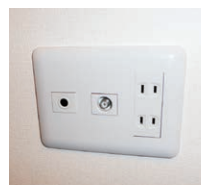
電話線用配管
