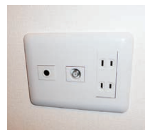
電話線用配管
