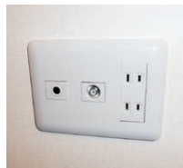
電話線用配管
