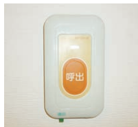
緊急通報装置(2箇所)
