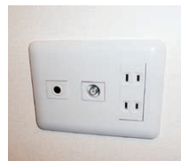
電話線用配管
