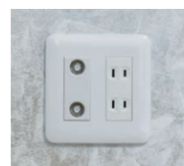
電話線用配管
