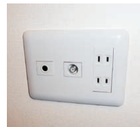
電話線用配管
