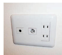
電話線用配管
