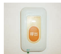
緊急通報装置(2箇所)
