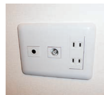
電話線用配管
