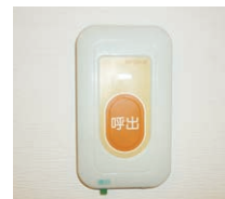
緊急通報装置(2箇所)
