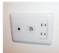
電話線用配管
