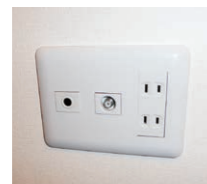
電話線用配管
