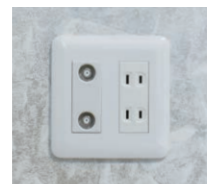
電話線用配管
