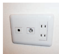
電話線用配管
