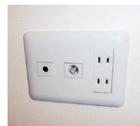
電話線用配管
