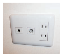
電話線用配管
