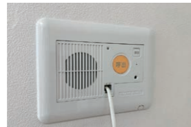
緊急通報装置(2箇所)
