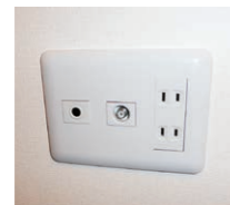
電話線用配管
