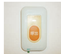
緊急通報装置(2箇所)
