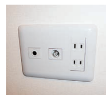
電話線用配管
