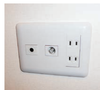
電話線用配管
