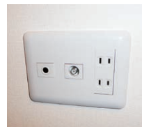
電話線用配管
