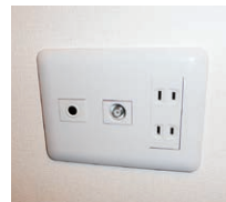
電話線用配管
